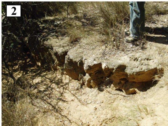
2 Astien présent sous les vignes et affleurant en bancs dans un fossé
